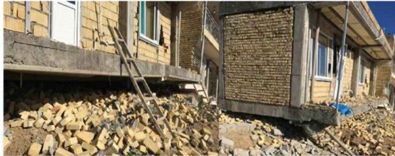
شکل ۵-۷- نمایی از موده‌های شکست پیچشی
